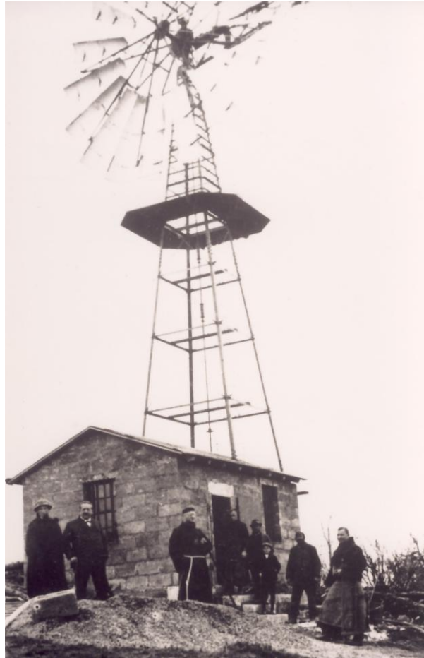
Fr. Medulf (rechts im Bild), der sich bei der Beschaffung des neuen Hochkreuzes besonders auszeichnete, wurde beim Aufstellen des Kreuzes schwer verletzt. Die Aufnahme zeigt ihn bei der Übergabe der 1921 aufgestellten Windkraftanlage auf dem Kreuzberg. Auf dem Foto, das von Alfred Saam zur Verfügung gestellt wurde, sind weiter u. a. zu sehen Ingenieur Ferdinand Schneider und Guardian Odorius Röder.
